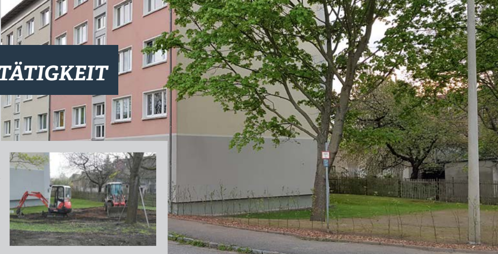
Gubenstraße, Entfernung alter Wegeinfassungen und Wildwuchs im Giebelbereich
